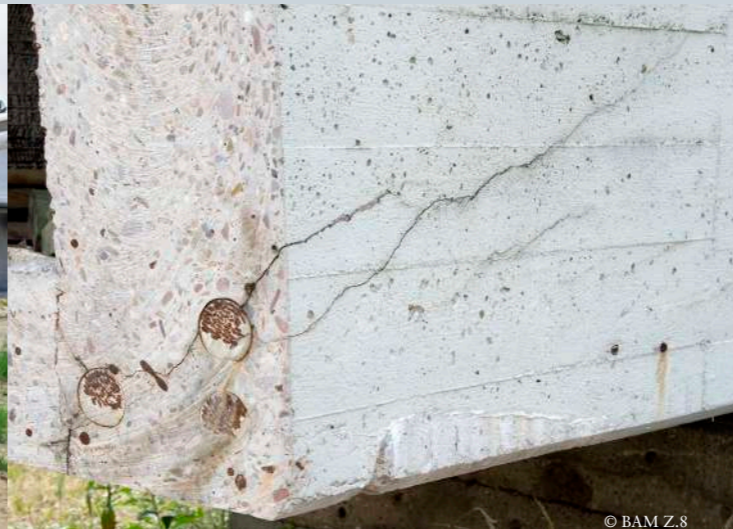
Originaler Brückenträger mit Rissbildung
